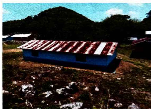
Foto 4: VISTA AL TECHO DE LA ESCUELA
